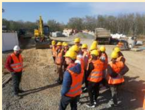
Obrázek 11: Studenti SŠ a SOU - exkurze na stavbě
